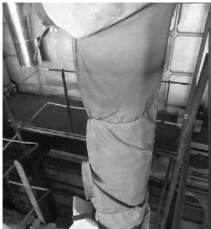
Рис. 2. Теплоизоляционный чехол с аэрогелевым волокном в составе, смонтированный на Казанской ТЭЦ-3
